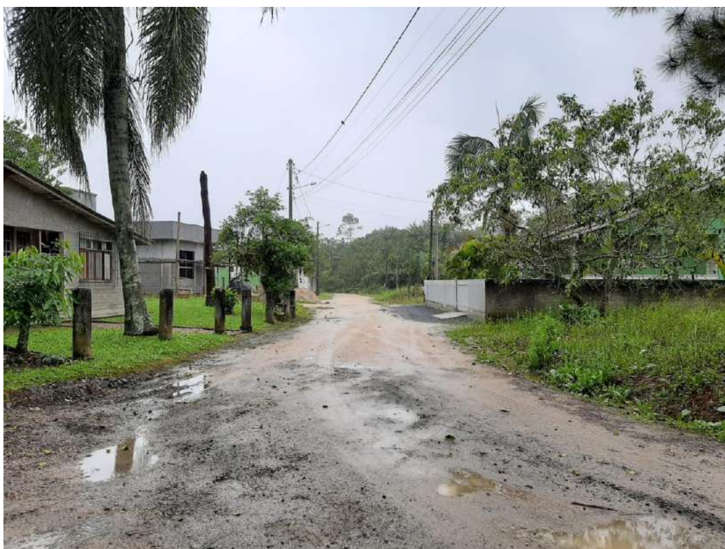
Rua Pedra Ronchi Genuíno/ Rua 3122
