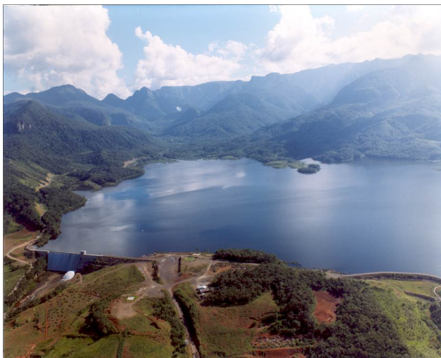
Figura 14 – Vista aérea da Barragem Rio São Bento (BRBS). Fonte: CASAN, 2005.
