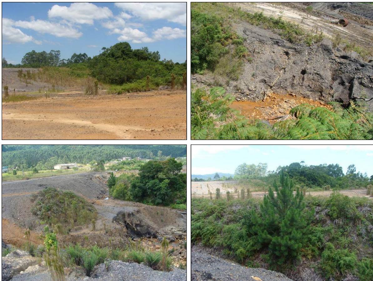
Figura 25 - Vista parcial da paisagem das áreas mineradas observadas na UTAP do rio Sangão, Siderópolis, SC. Fonte: IPAT/UNESC, 2010.
